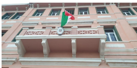
(il nuovo balconcino delle scuole in Via Vittorio Veneto)
